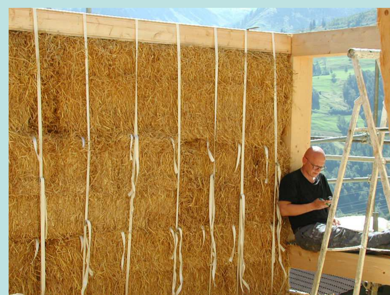
Lasttragende Strohballenwand mit Vorspannung
